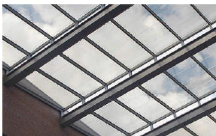
Cette toiture photovoltaïque est un vitrage de propriétés bioclimatiques multifonctionnelles qui génère non seulement de l'électricité propre et gratuite grâce au soleil, mais aussi favorise le passage de la lumière naturelle plus homogène pour illuminer l'intérieur de l'espace.
